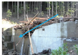
流木・土砂の流出を抑制する 流木捕捉型治山ダム(丹波市)
