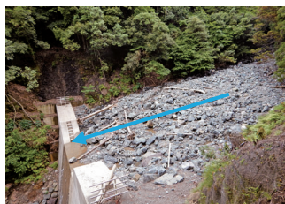
土砂の流出を抑制する 治山ダム(養父市)
