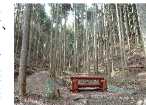
伐採木の除去と災害緩衝林整備、簡易流木止め施設の設置
