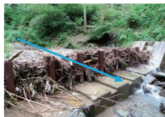
流木・土砂の流出を抑制する 流木捕捉型治山ダム(佐用町)
