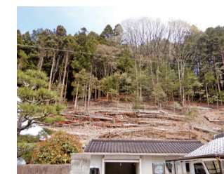
集落裏山の危険木伐採（姫路市）
