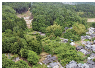
人家等保全対策を目的とした治山ダム（朝来市）
