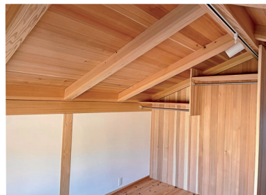
写真3 スギ桁目板3層クロスパネル施工事例
