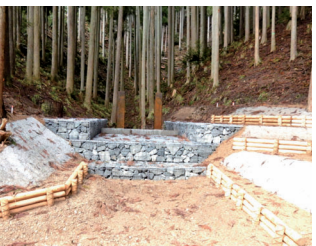
災害緩衝林と簡易流木止め 施設の整備（市川町）
