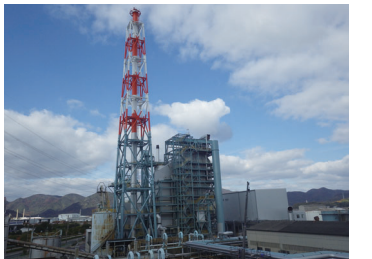
木質バイオマス発電所
