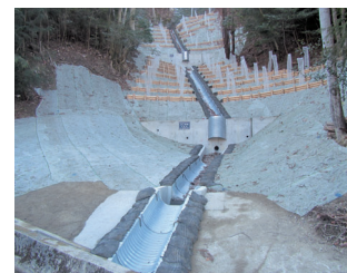
山腹工による保安林復旧（猪名川町）
