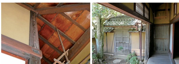
クリ柱とマツ桁・隅木・垂木・野地板 表の間、縁から門を望む
