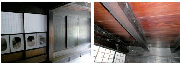
ケヤキの大黒柱他（玄関土間周り） アカマツの梁と天井板（みせの間）
