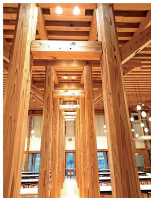
積雪荷重に耐える重厚な構造
