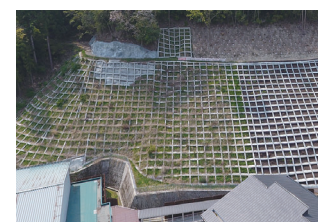
山腹斜面对策を目的とした法枠工 (猪名川町)
