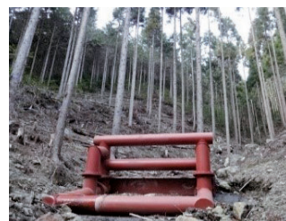
災害緩衝林と簡易流木止め 施設の整備 (丹波市)
