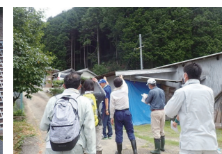
集落裏山の点検 (加古川市)
