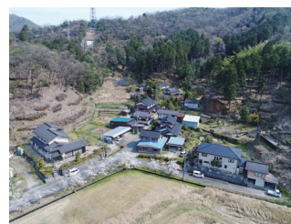
集落裏山の里山防災林整備 (豊岡市)
