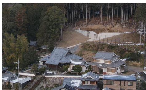
人家等保全対策を目的とした治山ダム (丹波市)
