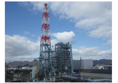
バイオマス発電所
