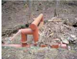
簡易流木止め施設による流木の捕捉 (多可町)
