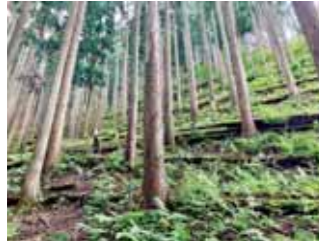
伐倒木を利用した土留工 (養父市)
