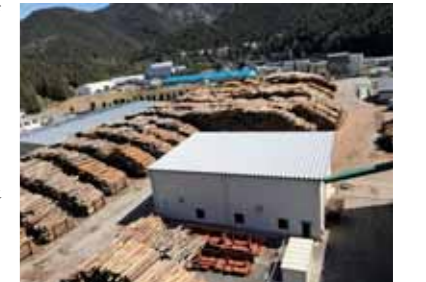
バイオマス発電所
