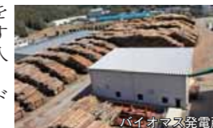
バイオマス発電所
