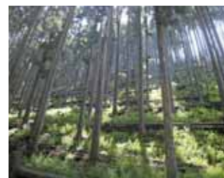
土留工の設置と植生回復
