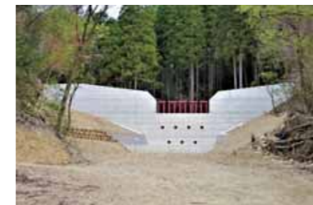
流木捕捉機能を持つひょうご式治山ダム（神戸市北区）
