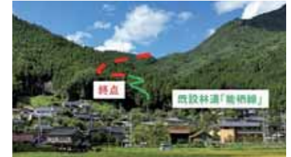
既設林道を繋ぐ支線林道（能栖線）
