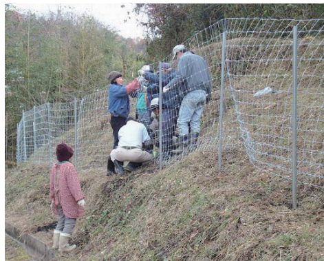
【集落住民による獣害防護柵の設置】
