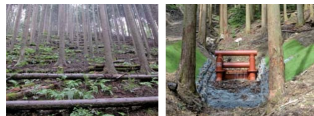
土留工の設置
