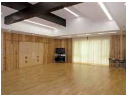
内装壁CLT貼り (神戸市立熊野地域福祉センター)
