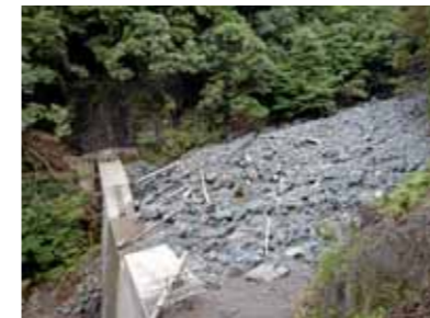
H30.7豪雨で発生した土砂・流木を治山ダムが捕捉(養父市大屋町)
