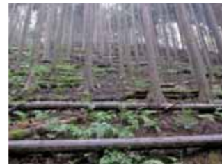
土留工の設置
