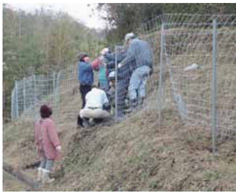
【集落住民による獣害防護柵の設置】
