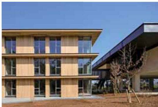
(株)竹中工務店 竹中研修所「匠」新館(川西市)
