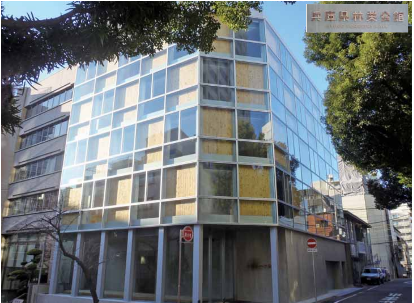
竣工間近の新兵庫県林業会館
