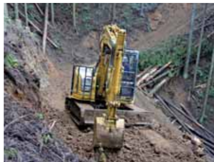
「森林作業道オペレータ研修(神河町)」
