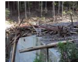
治山ダムが流木・土砂を捕捉(丹波市)
