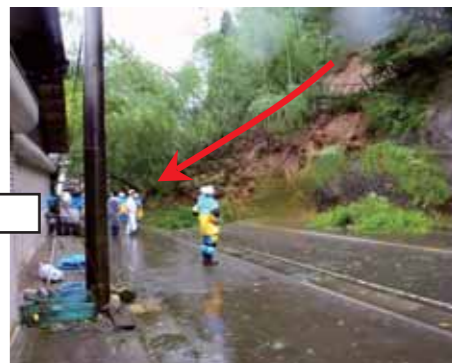
写真1 台風21号により県道・町道が山腹崩壊で一時的通行止(香美町) 左の写真は応急復旧後
