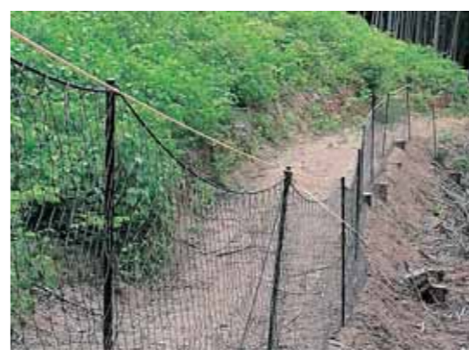
写真3：支柱上端に単独のロープを追加
