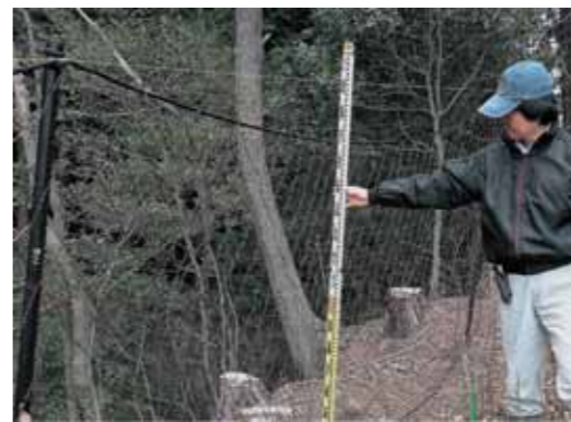
写真2：水糸と箱尺によるたるみ計測
