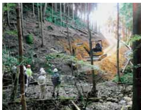
作業道整備の实地講習 (姫路市安富町)
