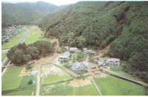
土砂流出等による人家等被災状況
