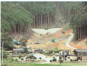
治山ダムによる復旧状況
