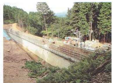
長さ100mの治山ダム
