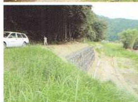
林道の復旧状況
