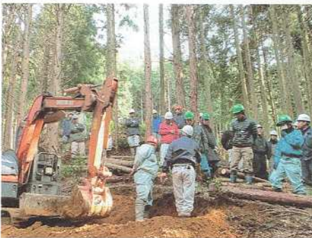
森林作業道の線形、施工の検討状況
