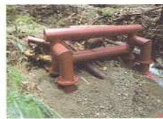
簡易な土砂捕捉と流木止め施設(姫路市)
