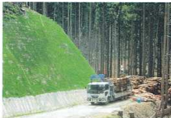
全線開通した「八木谷・大谷線」からの木材搬出 (養父市)
