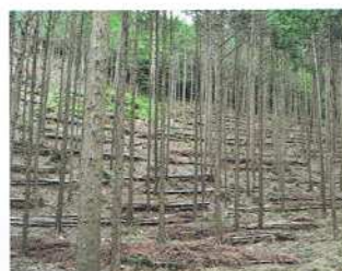
土留工の設置
