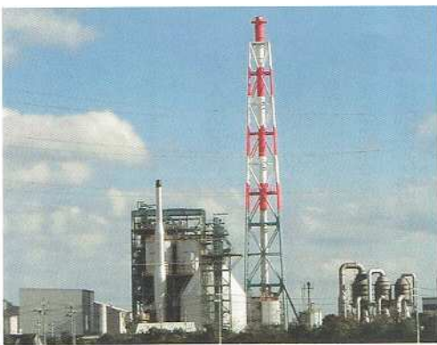
木質バイオマス発電施設
