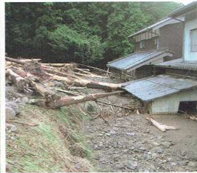
写真2 家屋に流れ込んだ土石流 (丹波市市島町)
