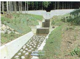
治山ダムの整備 (丹波市)
